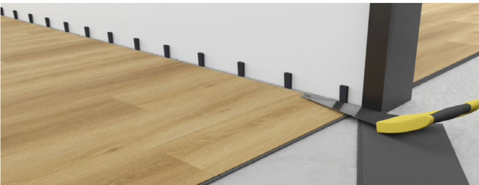
Puertas y rodapiés: Coloque un tablón (con el lado decorativo hacia abajo) al lado del marco de la puerta como se muestra en la figura. Luego deslice el tablón debajo del marco. / Door moulding and skirt boards: Lay a plank (with the decorative side down) next to the door moulding and saw as shown in the figure. Then slide the floorboard under the moulding.
