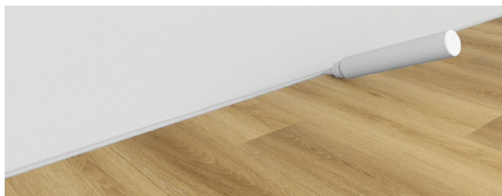
En cuartos de baño dejar 10mm. de junta de expansión y rellenar con silicona. / Be sure to leave 10 mm. expansion gaps and fill them in with a premium silicone-based sealant.
